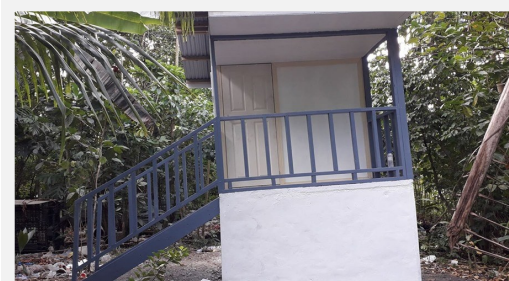
Compost Toilet— Buada
